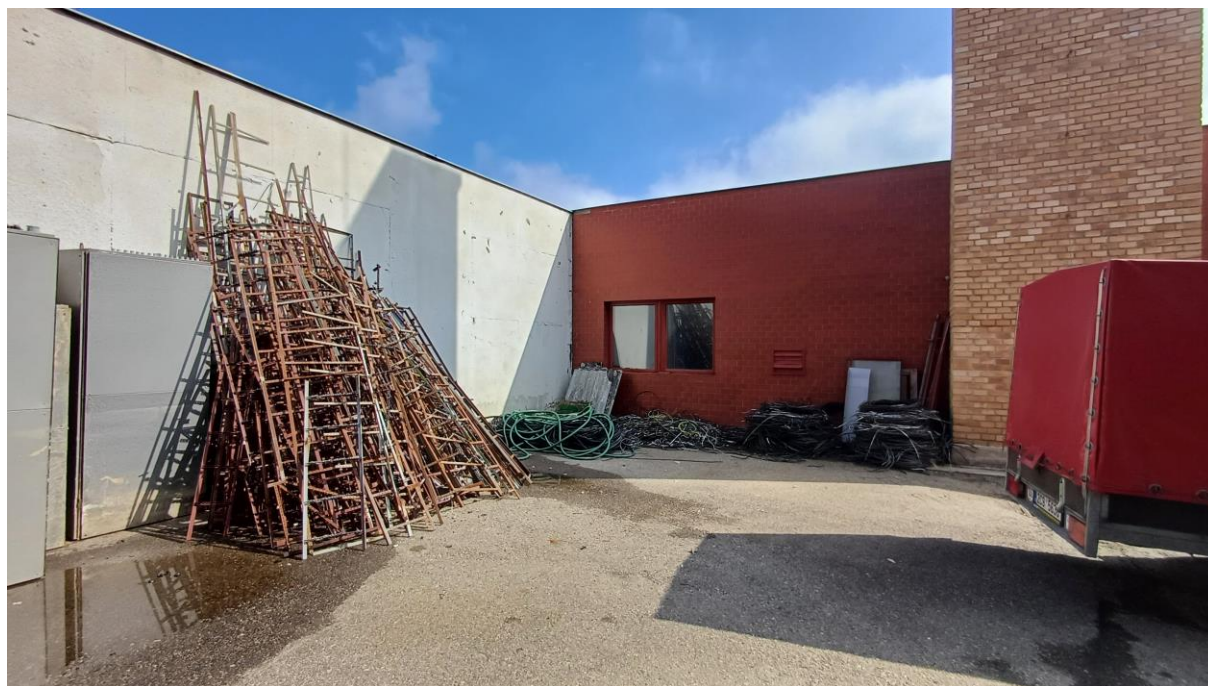
Azbestocementové desky opřené v rohu dvora
